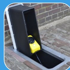
Figuur 4: Laadpunt in de grond (Streetplug)
