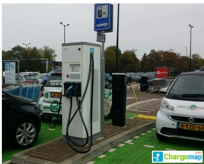
Figuur 15: een semi-publieke snellader met daarnaast een reguliere laadpaal op het dak van een parkeerplaats bij Winkelcentrum Middenwaard in Heerhugowaard (Bron: Chargemap.com)
